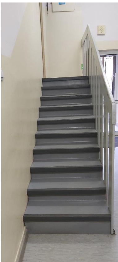
Schody wewnętrzne w Filii Przedszkola nr 286.
